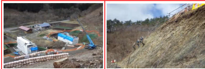
④施工：三好建設
