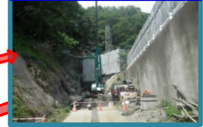
トンネル防護用土留め設置作業
